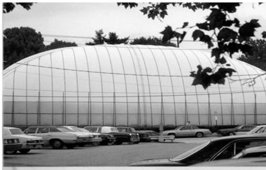
*Рис. 8.2. Пример куполообразного сооружения с применением ФП.*
